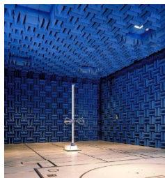
(株)東陽EMCエンジニアリング 川崎計測センターの電波無響室
